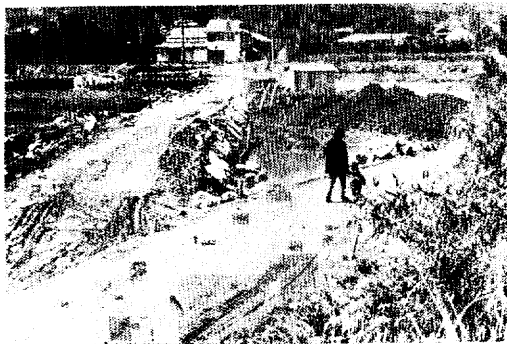
右側のカーブを直線に改良中の鳥栖～牛原線
