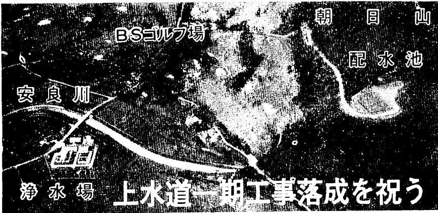
朝日山中腹の配水池とそのふもとの浄水場
