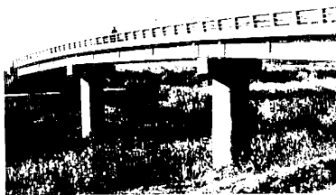
高岡橋、橋脚築造工事が43年に完成、安全で快適に歩かせる計画が立てられている
