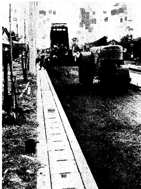
舗装工が進む中央通り（12月2日うつ）
