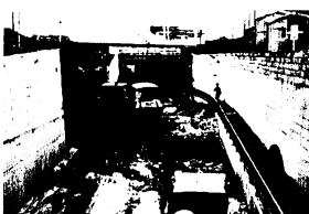
取付道工事中の藤木地下道
