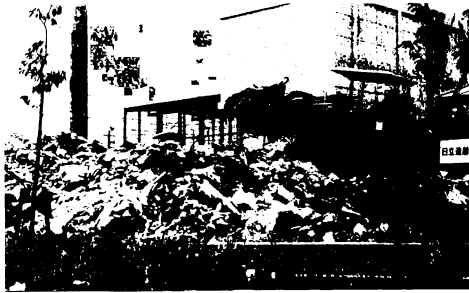
処理場内にたまったごみ。後は建設中の新焼却場。
