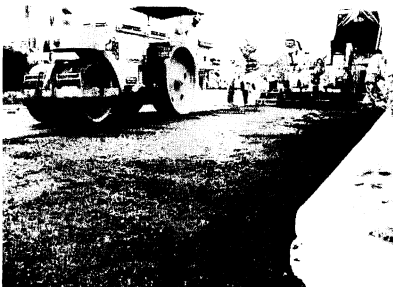
進む道路の舗装
