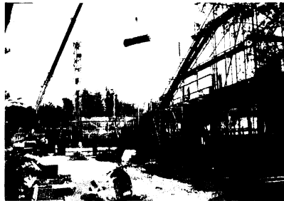
体育館棟の老朽校舎をこわして3階建の校舎を建設中の鳥栖小
