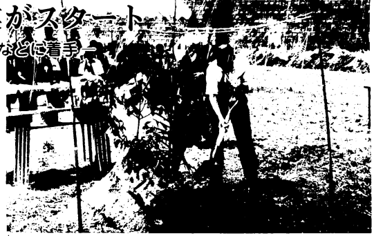
8月7日、区画整理の現地で起工式
