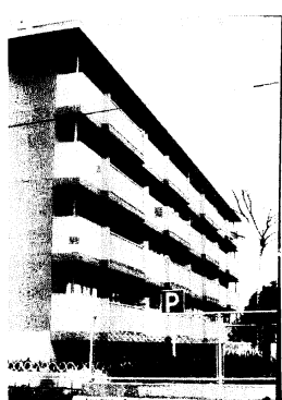
完成した16戸の市営アパート
