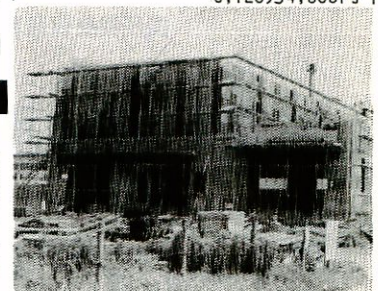
▶建設がすすむし尿処理施設
