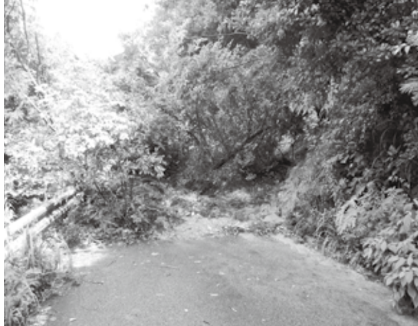
大雨によって、昨年市内で起きた土砂崩れ
