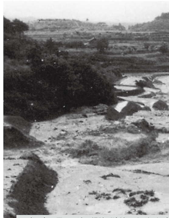
28水で亀の甲ため池の堤防が決壊し、濁流が一気
