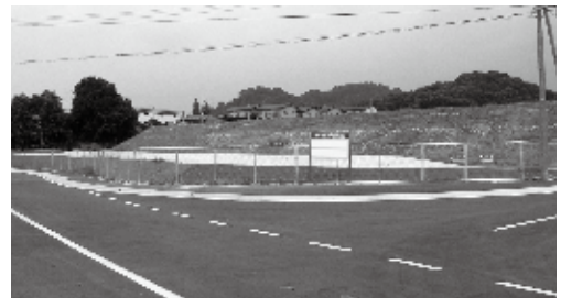
産業団地造成事業で整備された西部第二工業団地
