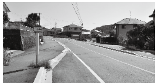
道路の拡幅工事をし歩道を整備した村田町住宅・平田線
