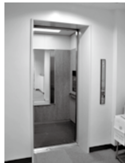
麓公民館に新たに設置されたエレベーター
