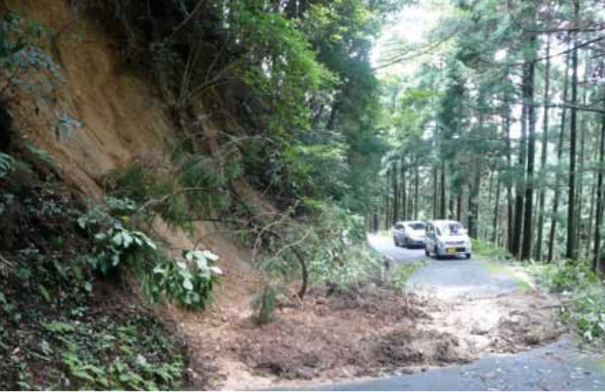
昨年7月の大雨により市内で発生したげけ崩れ
