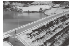
河内防災ダム
