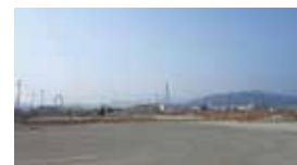
かさ上げ、造成が進む土地
