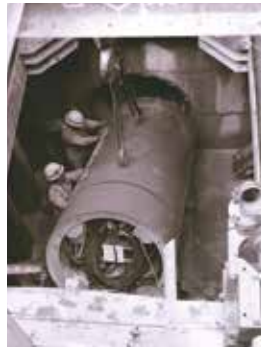
下水道の管きょ布設工事
