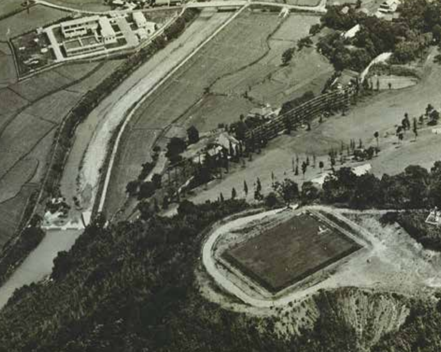
約50年前の配水池（右手前）と浄水場（左奥）。浄水場は現在の浄水場とは違うもので、現在の浄水場よりも南東約1キロに位置していた。
