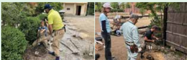
派遣者と現地マイスターが力を合わせて修復作業を実施
