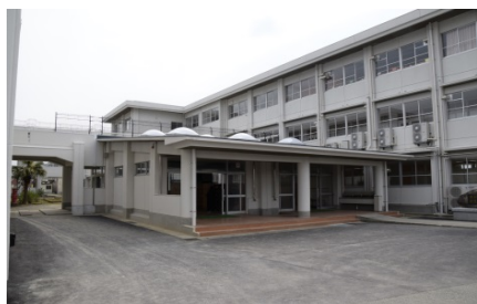
改修された校舎(昇降口)
