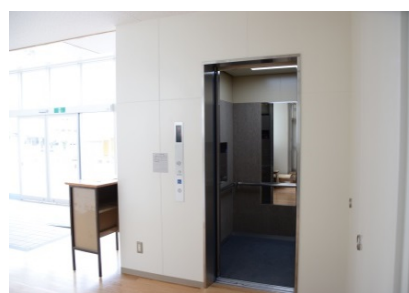
新設されたエレベータ
