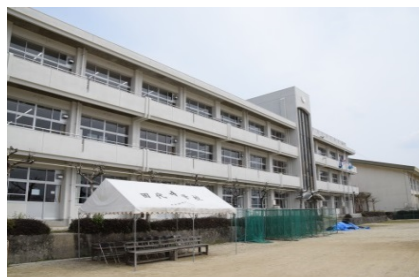
改修された校舎(グラウンド側)
