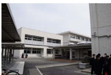
新駐輪場・昇降口・増築棟
