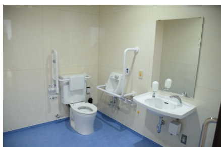
車椅子対応の新設トイレ
