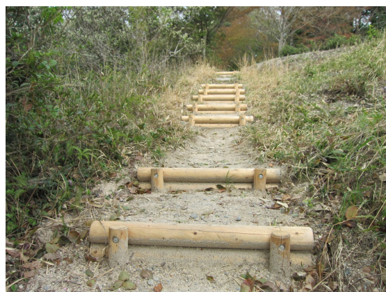
腐食階段の改修
