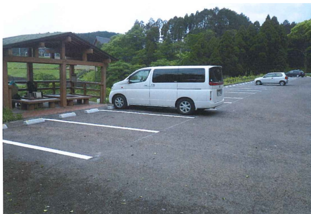
駐車場のライン引きと車止めの設置
