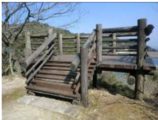
展望台床腐食部分の補修
