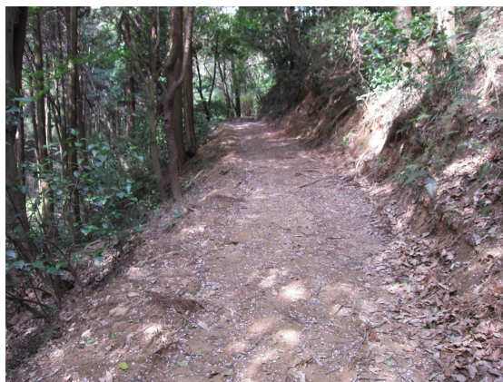
遊歩道の拡幅整地
