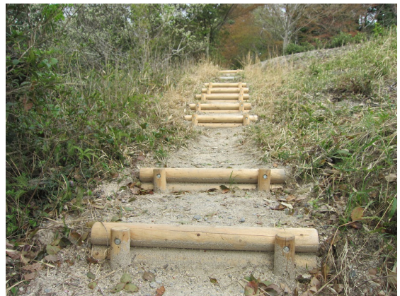
腐食階段の改修
