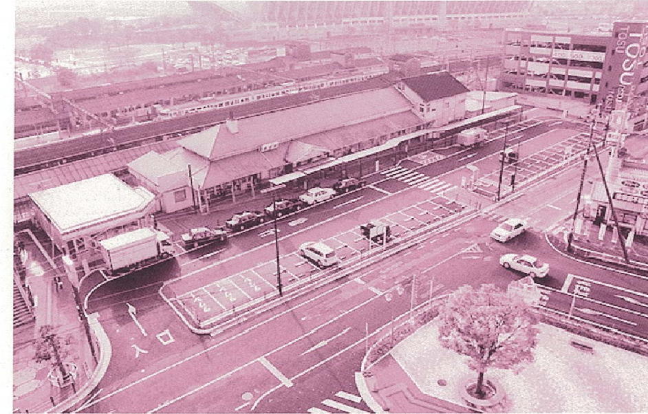
整備後の鳥栖駅前周辺の様子
