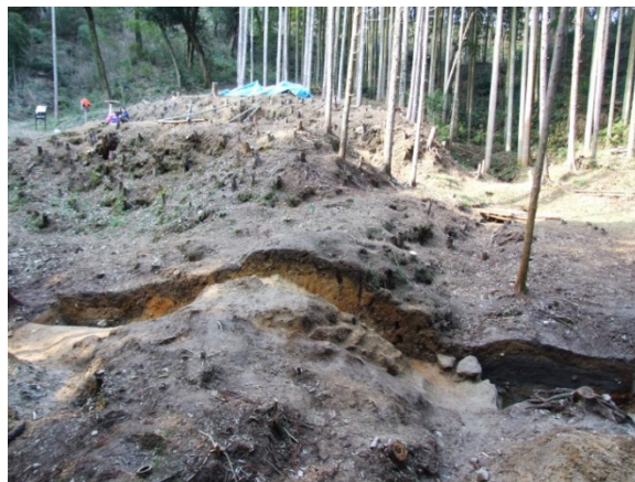
上：空堀 下：土塁及び水路
