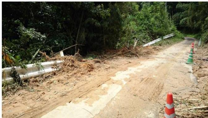
5. 土砂崩落によるガードレールの損壊
