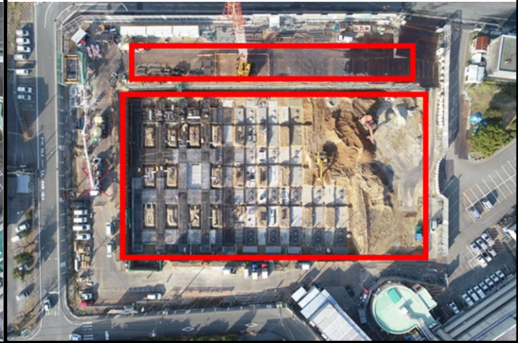
令和3年 12月末 新庁舎本館：基礎躯体工事 北別館：（仮設ヤード使用）
