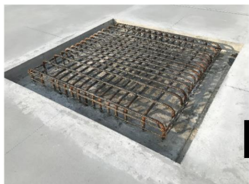
免震基礎 鉄筋組み
