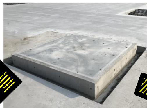
コンクリート打設
