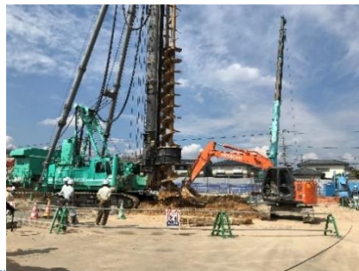
本館の基礎杭を施工しています。
