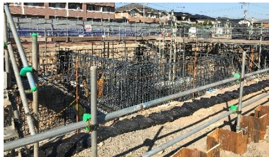
北別館の基礎配筋を施工しています。
