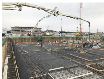
免震ピットの床のコンクリートを打設しています。
