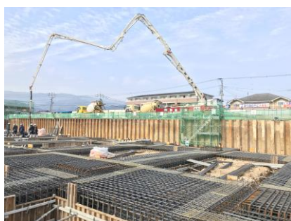
基礎地中梁のコンクリートを打設しています。
