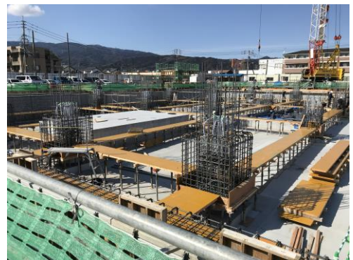
免震装置上部の躯体を施工しています。
