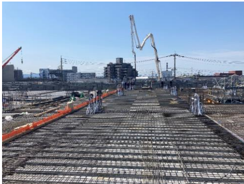
2階スラブ配筋を施工しています。
