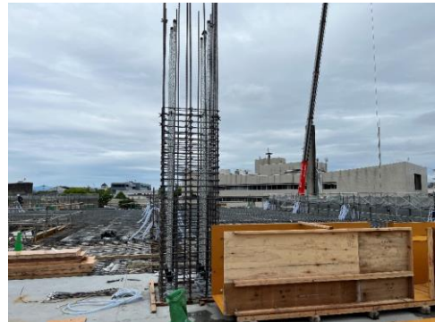
2階柱配筋を施工しています。
