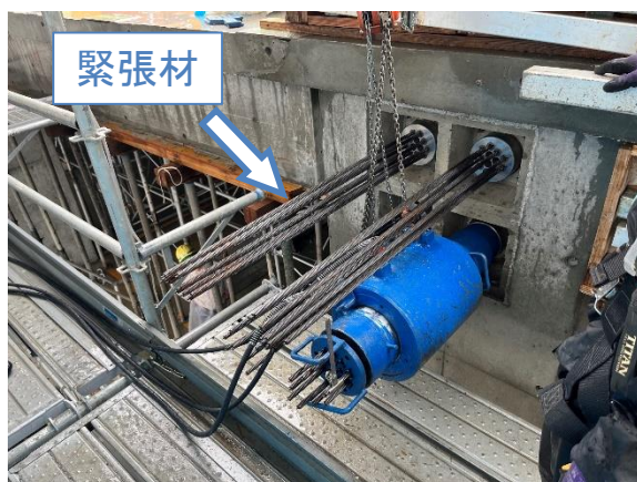
緊張材への圧縮力導入状況
