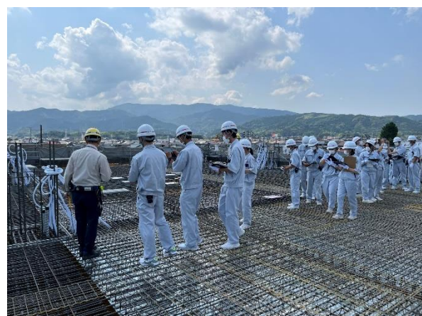
配筋状況の見学
