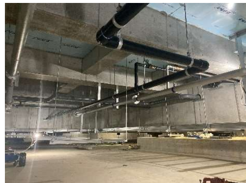
免震階の配管を施工しています。
