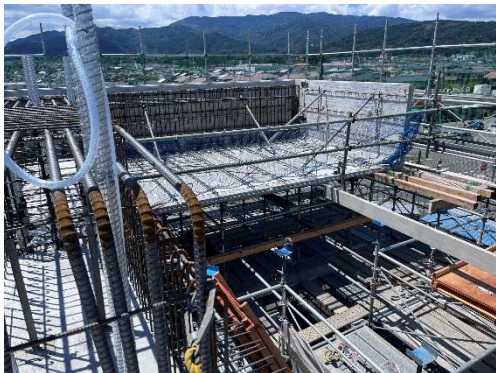
屋上大庇を設置しています。
