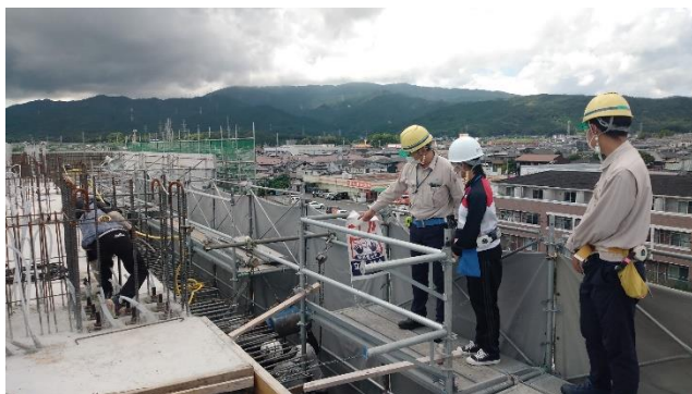
躯体工事の見学
