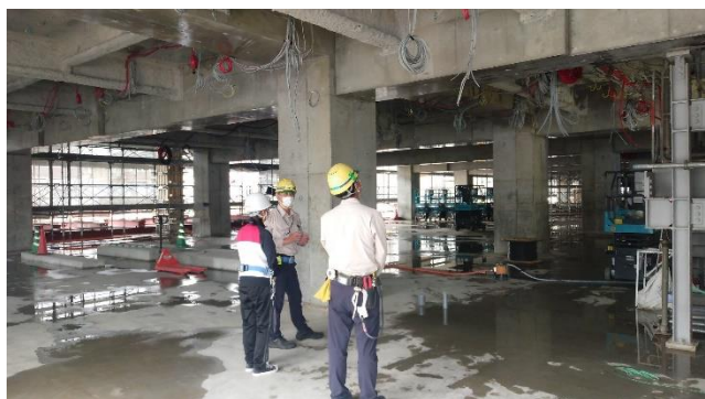
内装工事の見学
