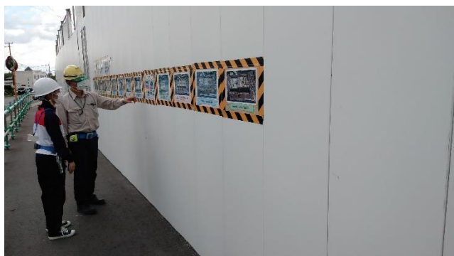
仮囲いの見学
